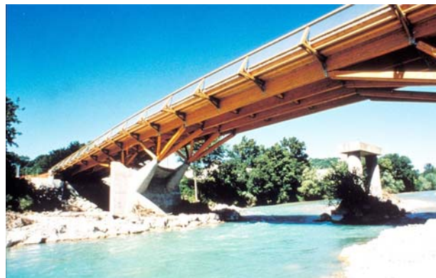
Pont à Crest (Drôme)
