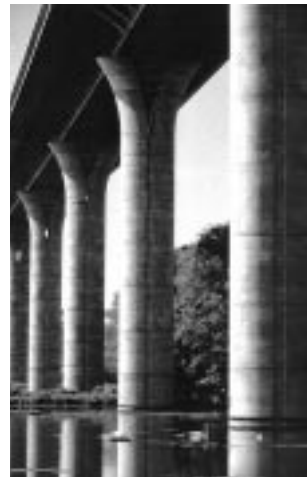
Viaduc du Scardon - A16 Architecte : J.-V. Berlottier, BET : Tonello
