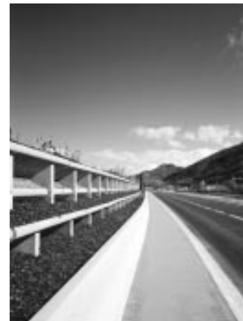
Aménagement routier à Digne Architecte : Hanrot Paysagiste : Rault
